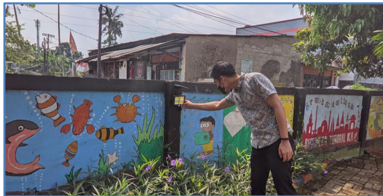
Gambar 5. Lampu Panel Surya yang telah Terpasang pada Pagar Sekolah
